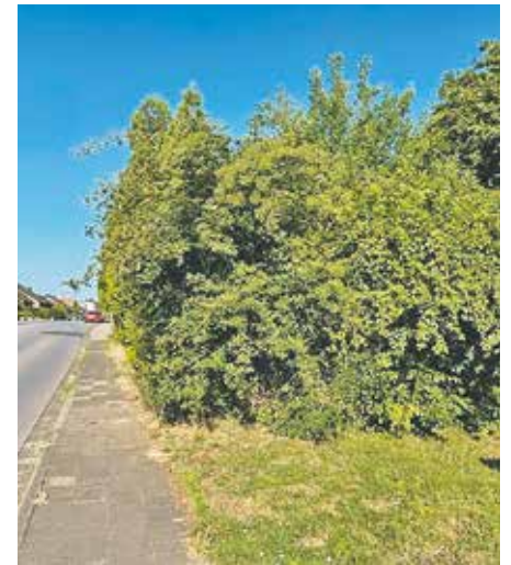
Hier ragt die Bepflanzung auf den Gehweg und sollte daher bis zur Grundstücksgrenze zurückgeschnitten werden.
